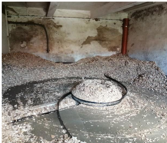
Nízke pôvodné pivničné priestory
